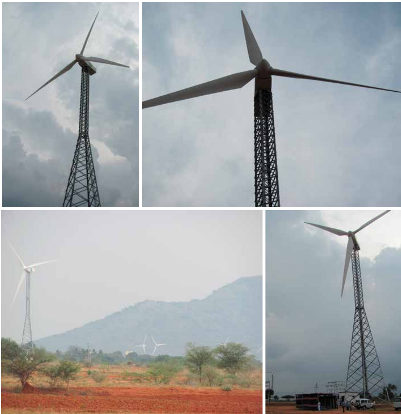
Photos from actual project
